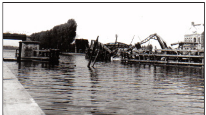
Opgeblazen spoorbrug te Willebroek in 1940
