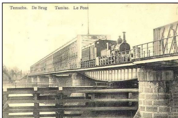
De eerste spoorbrug over de Schelde in Temse (1870) werd ontworpen door de beroemde ingenieur Gustave Eiffel.
