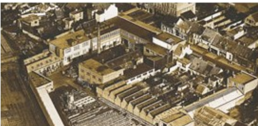
De firma op de Bernardsesteenweg in Hoboken
