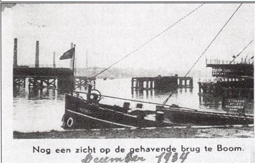
Na de aanbeuking van de brug over den Rupel te Boom : de „Alice” de stoomer dewelke het draaibare gedeelte van de brug uit haar fundamenteen lichtte.
