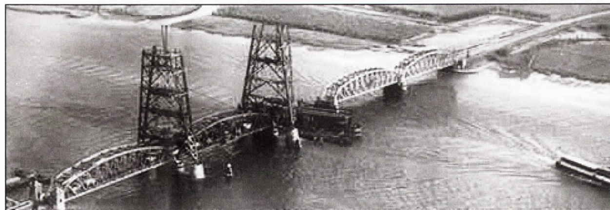
De Barendrechtse brug tijdens de bouw, vermoedelijk in 1932.
