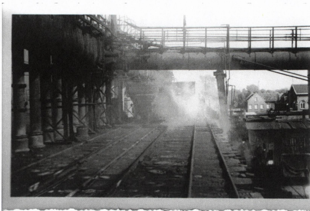
“Oven WK 3” - de bovenzijde tijdens het vullen met de stofkolen
