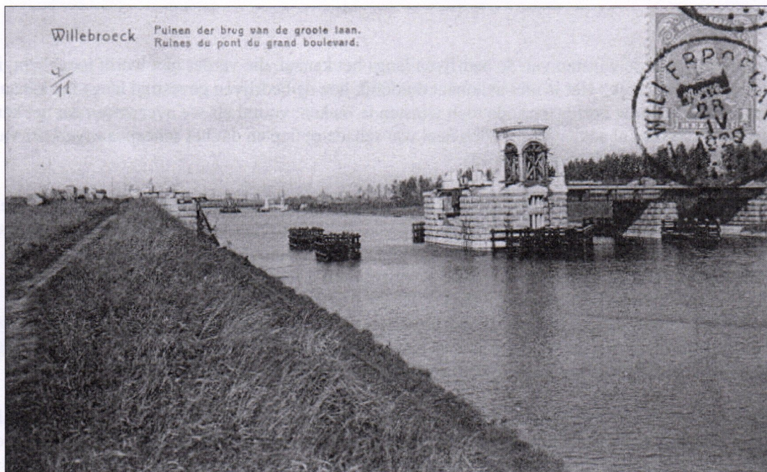
De algehele crisis en de schade die het Zeekanaal tijdens de eerste Wereldoorlog opliep, zoals hier de gedeeltelijke vernieling van de Boulevardbrug, noopten het bestuur van de 'Maritieme' tot buitengewone inspanningen en prijsstijgingen. (prentkaart collectie gemeentelijke openbare bibliotheek Willebroek).
