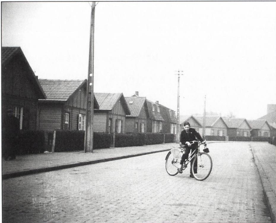
Noodwoningen (noodbarakken) opgetrokken door het KAF of Koning Albert Fonds
