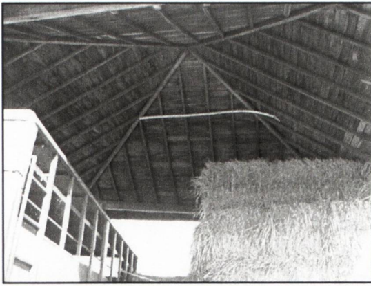
▲ Kap vervaardigd met balken en planken (Blaasveld-Heihoek) ▲ Dichtgemaakte wand - beschutting (Blaasveld-idem)
