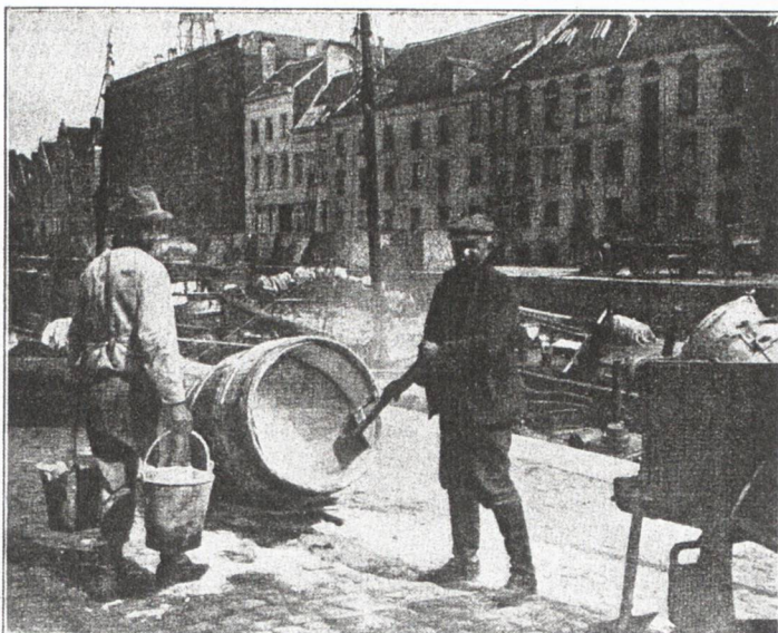
La désinfection des Bassins. — La saupoudration à la chlorure de chaux
