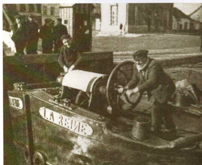
Boven: een zicht op het 'saske', de kapel en in de verte Boom. Onder: het binnenschip 'La Reine', met mensen op de kade en op de achtergrond het oude sashuis (afb. verz. G. Van Auwenis)
